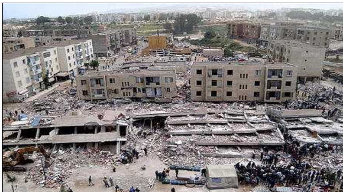
Figure N°20 : Les dégâts du séisme du 21 mai 2003 dans le Grand Alger
